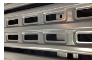
ボトム面には、鋼板をプレスした強度の高い部材を採用。
